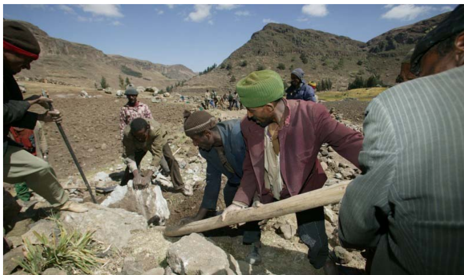
Hombres limpiando una carretera en Delenta, en la región de Amhara, como parte de un proyecto de Oxfam de “dinero por trabajo”. Fotografía: Oxfam/Crispin Hughes
