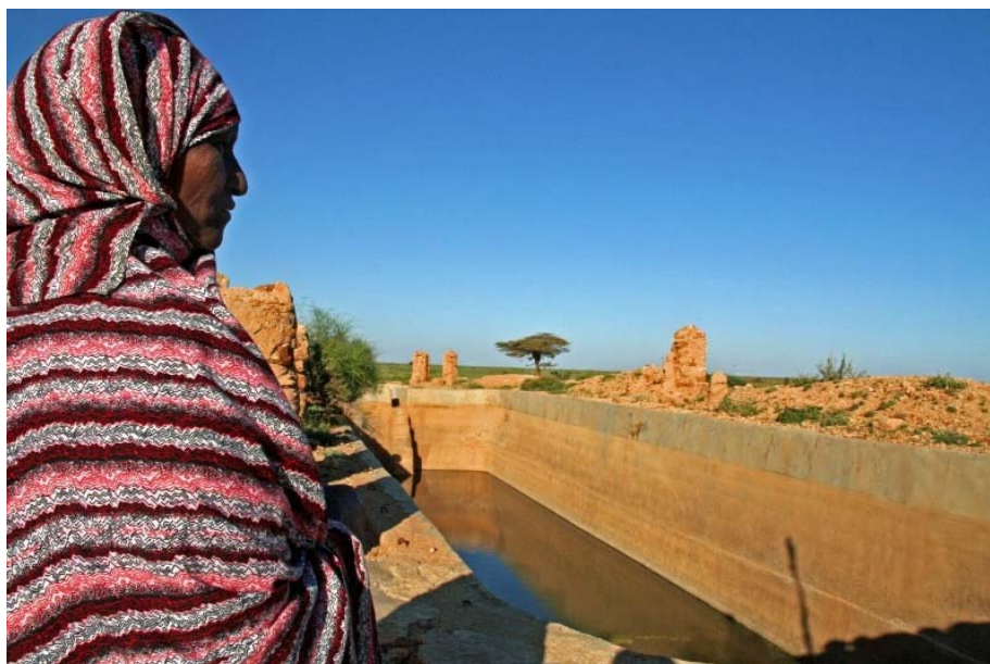
Sarahaa Malmud Muhumed junto a un birkhad construido por Oxfam, una alberca protegida donde se recoge agua de lluvia para utilizarla durante la larga estación seca, Harshin, Región Somalí, Etiopía. Derechos: Oxfam/Maite Álvarez.
