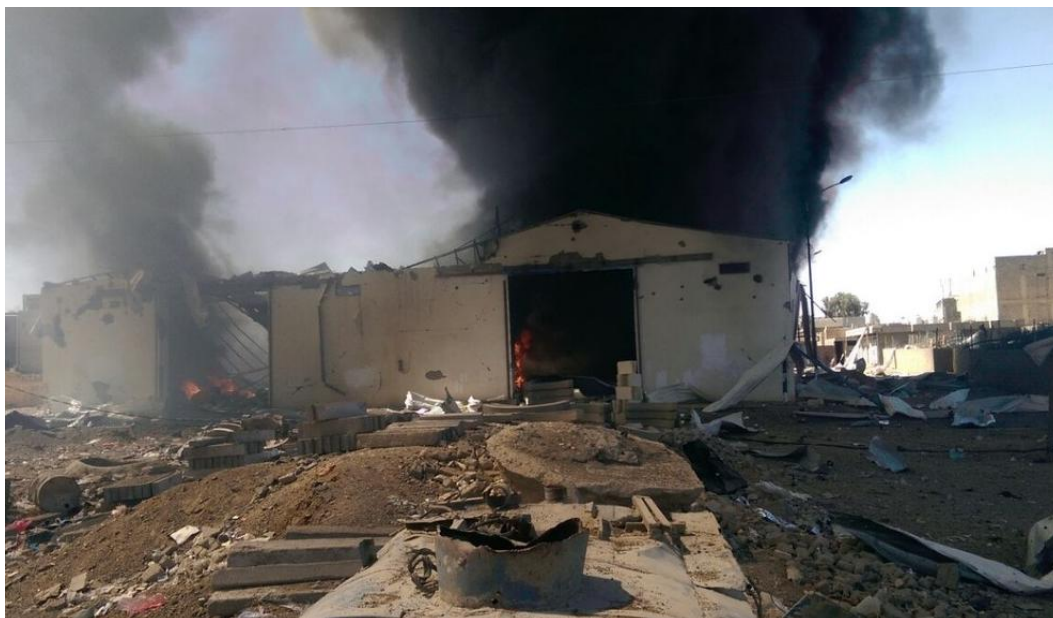
Entrepôt d'Oxfam à Saada, au Yémen, après une frappe aérienne en avril 2015. Photo : Oxfam
