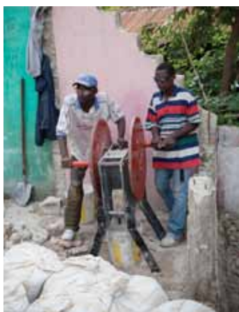
Porky (gauche) et Elizé (droite) concassent des décombres à partir des bâtiments détruits sur lesquels ils travaillent. Ils créent du granulats qui sera utilisé pour produire du béton pour les nouveaux bâtiments.
