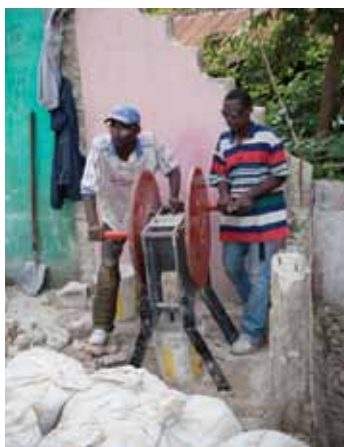
Porky (links) en Elizé (rechts) verbrijzelen puin uit de vernielde gebouwen waarin zij staan. Het gruis wordt gebruikt in het beton voor nieuwe gebouwen.
