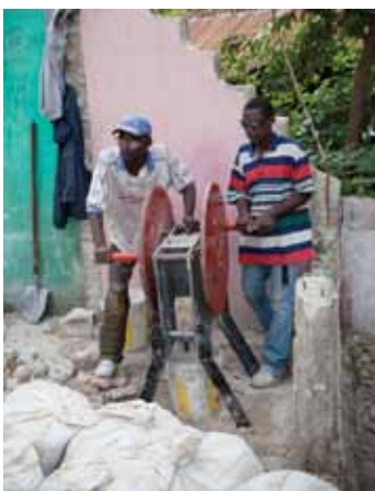
Porkey (agoch) ak Elizé (adwat) ap kraze dekonb ki soti nan batiman kote yo kanpe an. Y ap rasanble ranblè pou yo fè beton pou yo sèvi pou fe siman pou konstwi nouvo batiman.
